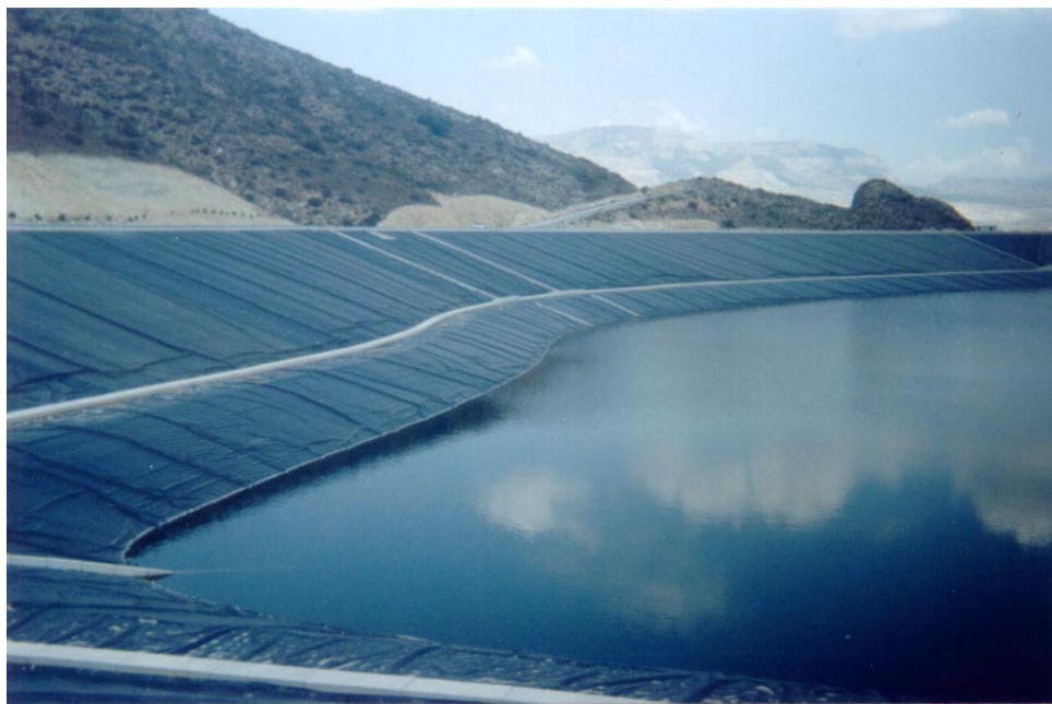
Foto 6.2.. Detalles de bermas en mitad del talud. Sierra del Aguila. Orite. Alicante.
