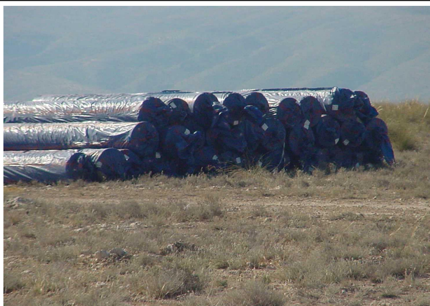
Foto nº 6. 8. Acopio de láminas en la obra.
