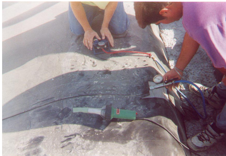
Foto n°. 7. 3. Prueba de la doble soldadura en PEAD.
