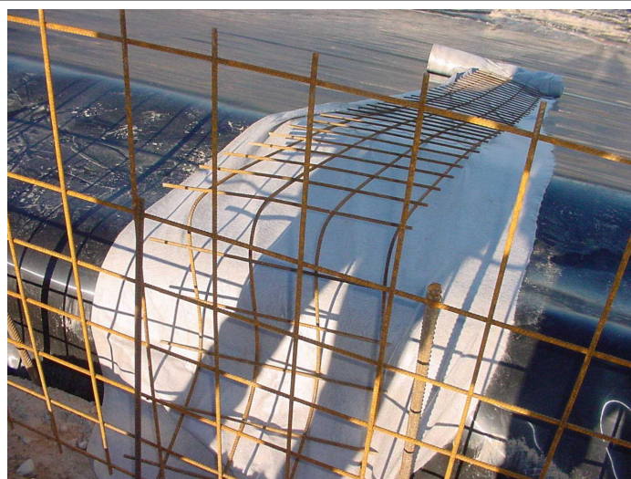
Foto 5.4.. Lámina de poliéster para realizar maestra de hormigón en talud.
