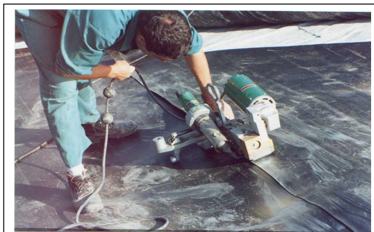
Foto 6..4. Soldadura por termofusión de cuña de aire caliente.
